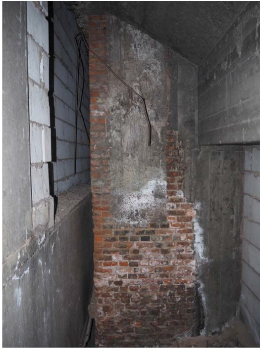
Betonnen elementen werden tegen de bakstenen wand gestort (zijdelings). Hierboven zie je een restant van een latere betonnen tribune die werd afgesneden bij de bouw van het ICC in de jaren'70.
