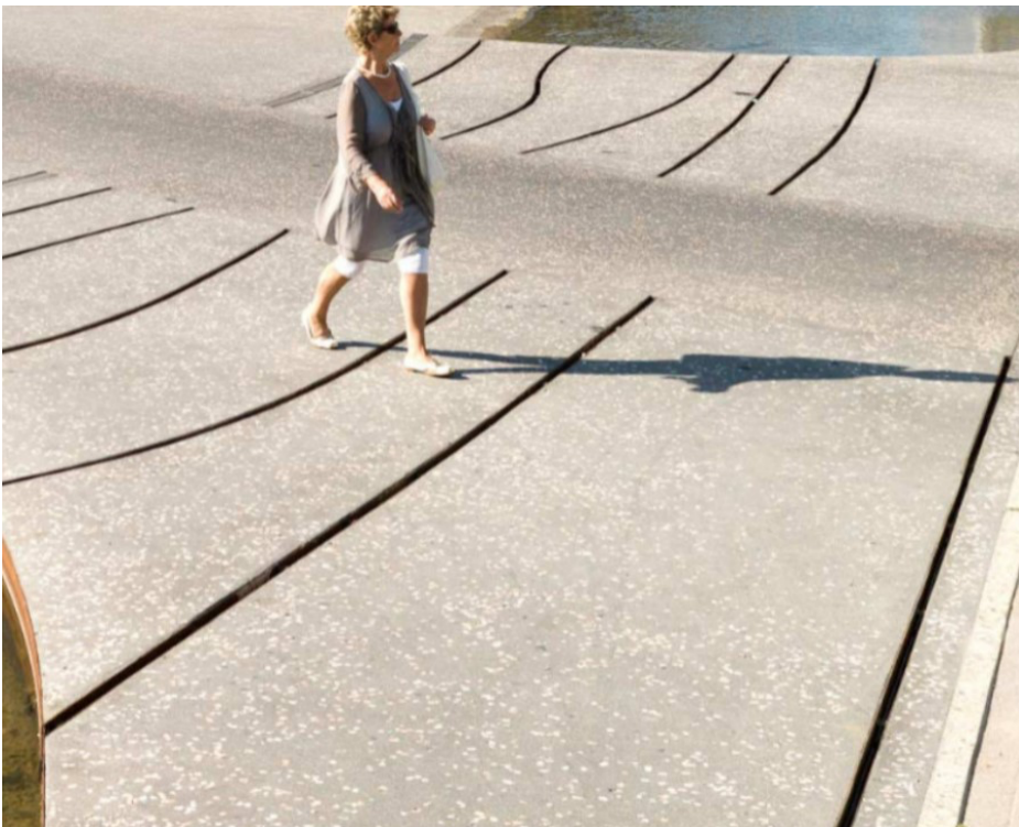
Referentiebeeld voor asfalt met ingestrooide granulaten parkpassage: Project met ingestrooide, gepolijste geitasfalt (referentie Karres en Brands)
