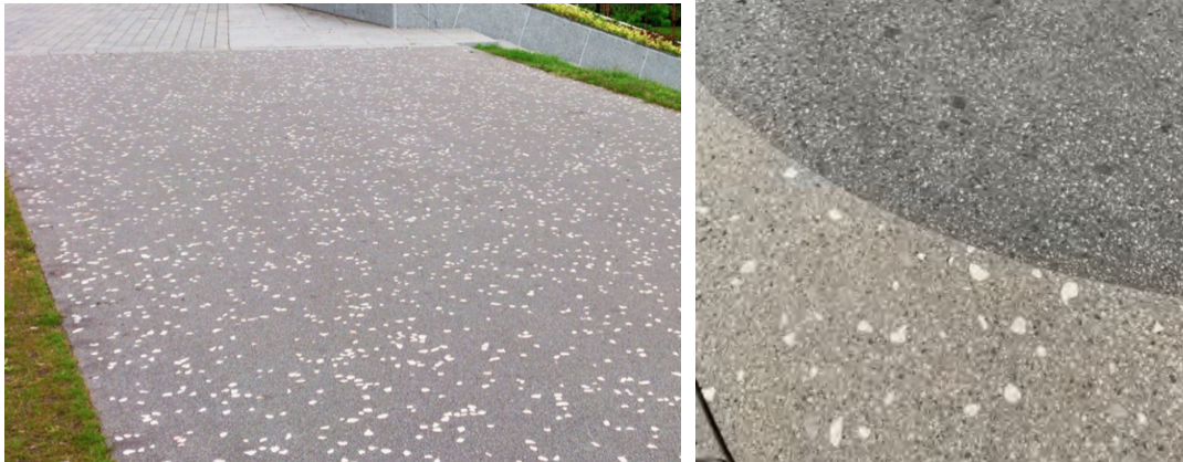
Referentiebeeld voor asfalt met ingestrooide granulaten parkpassage.
